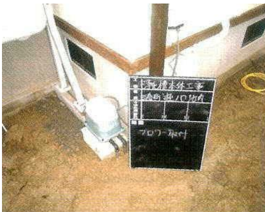
【写真 7】 ブロア設置状況を示す写真
