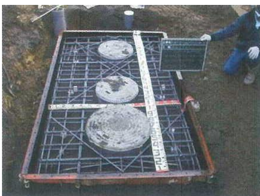
【写真 6】 上部スラブ工事を示す写真
