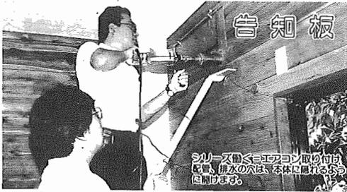
シリアスな顔でコネクティングを取り付け、配線、排水の穴は、本体に隠れるように隠れている。
