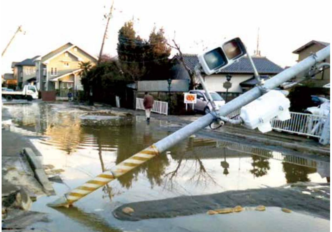
液状化現象で傾いた信号機と電信柱(布佐・都地区)
