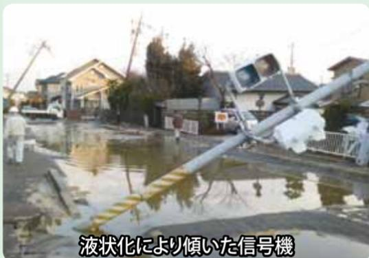
液状化により傾いた信号機
